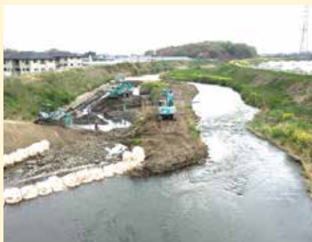
粕川堤防修繕
