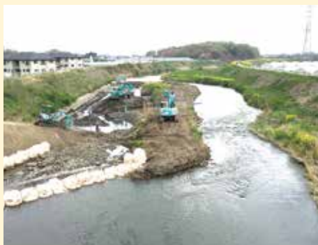
粕川堤防修繕
